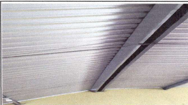
Mantenimiento a estructura de techo
